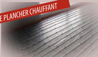
Le plancher chauffant basse température a pour principe de faire circuler de l'eau chaude dans des tubes noyés dans une chape ciment ou anhydrite.
